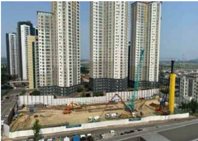
▼ 이안 인천 논현 주상복합 신축공사
