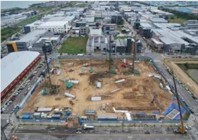
▼ 시화MTV 물류1부지 물류센터 신축공사
