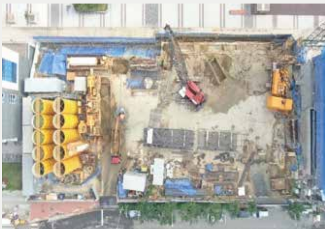
▼ 청라국제도시 C4-1-4 복합시설신축공사
